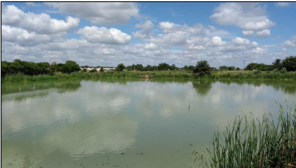
Figura 8. Laguna de tratamiento ubicada a continuación de la de la Figura anterior. Esta laguna es el último punto del recorrido antes del vuelco al cuerpo receptor.
