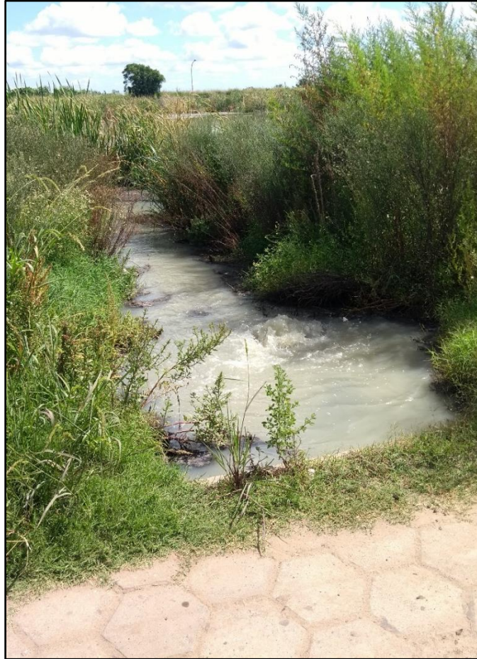
Figura 6. Bypass del efluente sin tratar desde la estación de bombeo hasta la antigua laguna de tratamiento.
