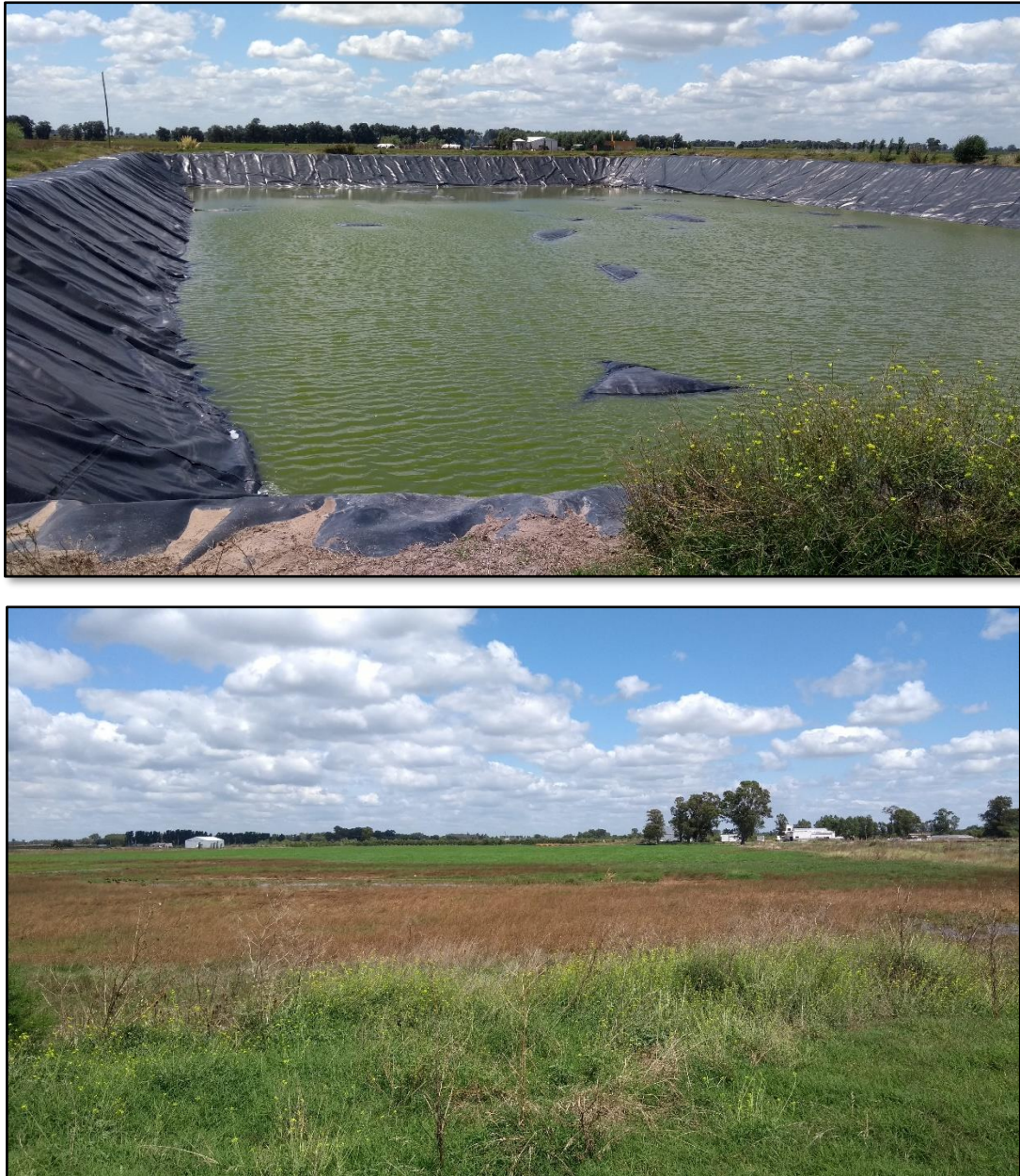
Figura 57. Relleno sanitario en construcción. Arriba: celda impermeabilizada. Abajo: predio del relleno sanitario. El bajo es de origen antrópico, debido a la extracción de material para la construcción de la celda.
