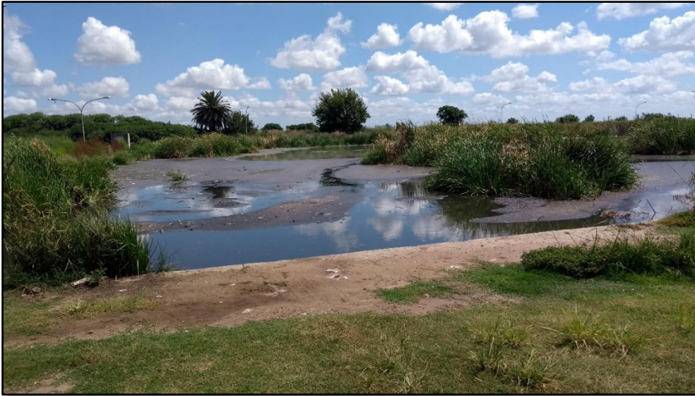
Figura 7. Antigua laguna de tratamiento donde se descarga el efluente sin tratar.
