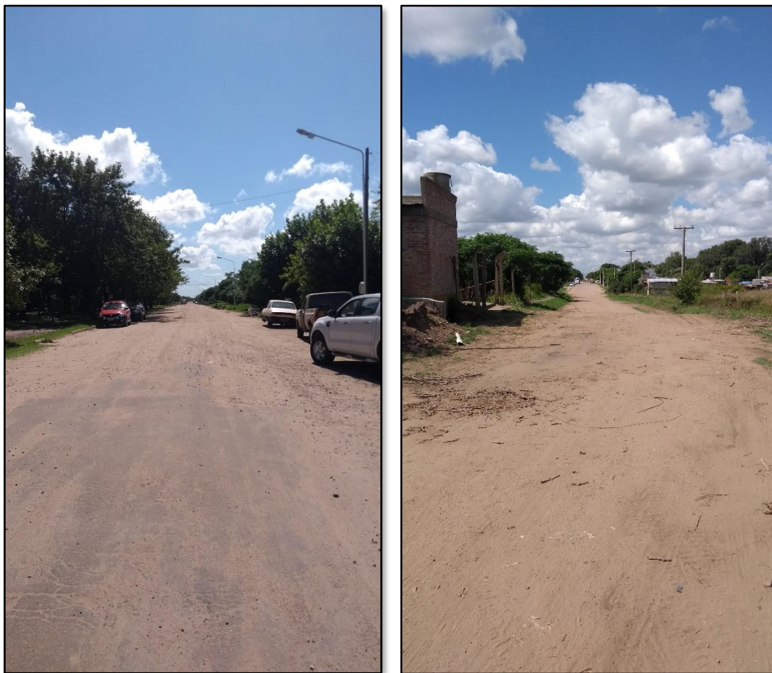
Figura 2. Calles de acceso al predio de la planta actual. Izquierda: calle Pellegrini, permite acceder a la entrada suroeste que se ubica sobre la calle Echeverría. Se observa un pequeño tramo pavimentado correspondiente a la extensión de una calle ortogonal. Derecha: Avenida Balcarce, permite acceder a la entrada noreste, entrada de los camiones atmosféricos.
